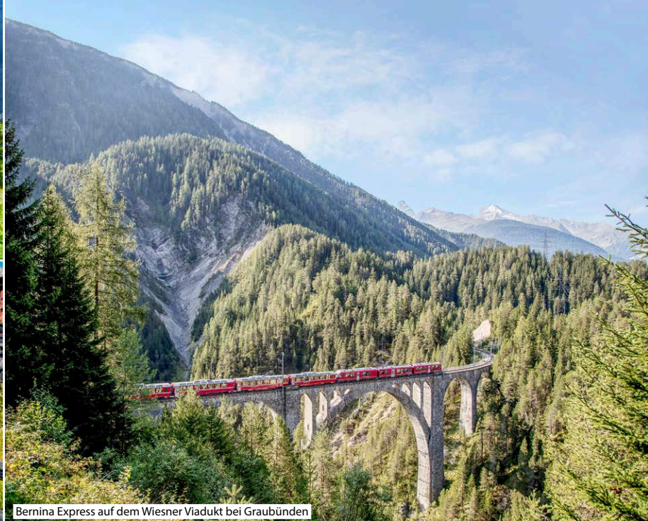
Bernina Express auf dem Wiesner Viadukt bei Graubünden
