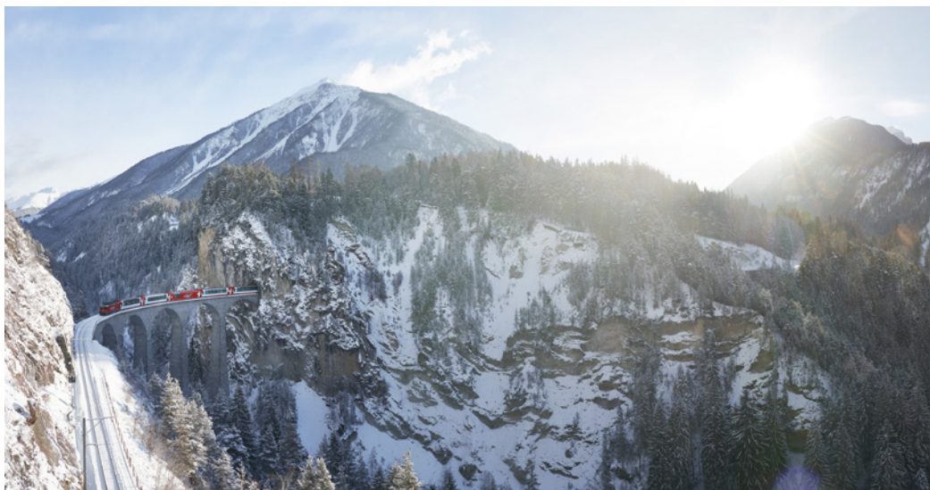
Glacier Express auf dem Landwasser-Viadukt
