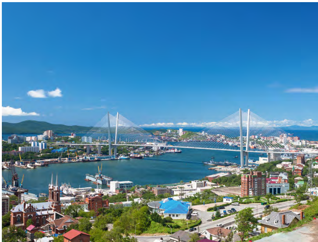
Solotoi-Brücke in der Hafenbucht Wladiwostoks
