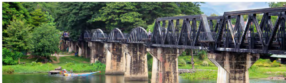
Brücke am River Kwai
