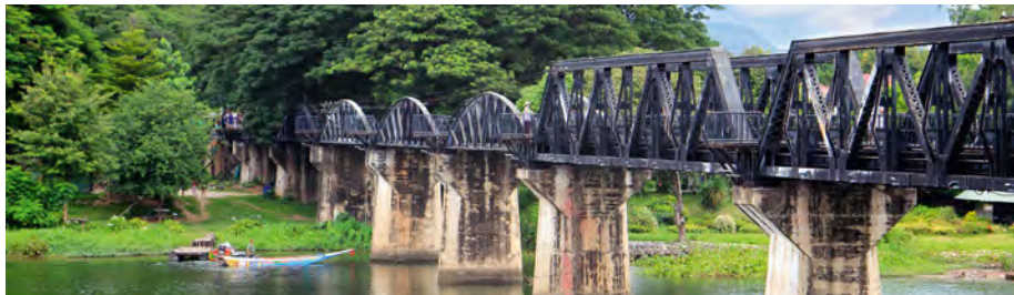
Brücke am River Kwai
