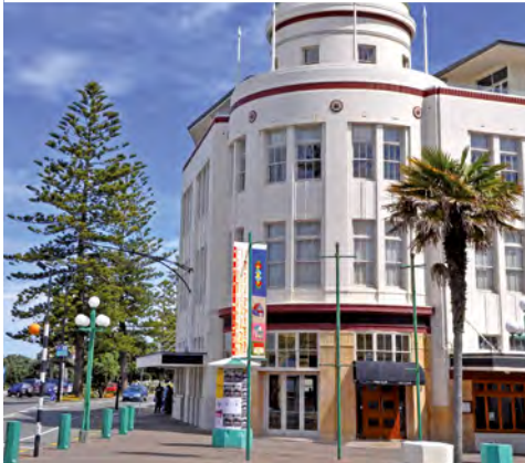
Art déco-Gebäude in Napier
